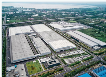
制造基地和零部件工厂 新改扩建工程
